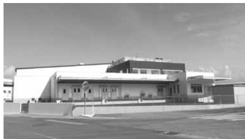
アレルギー専用室を設け、対応を行っていく南部学校給食センター
