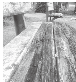
老朽化している公園のベンチ
