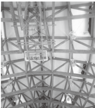
木造体育館の天井 （小菅村体育館）
