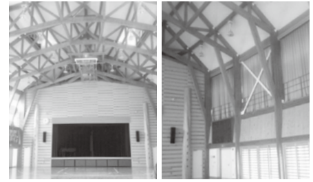
隣接する木造体育館（小菅村体育館）
