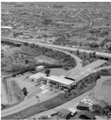
南アルプスIC 中部横断自動車道と新山梨環状道路が交差する交通の要衝
