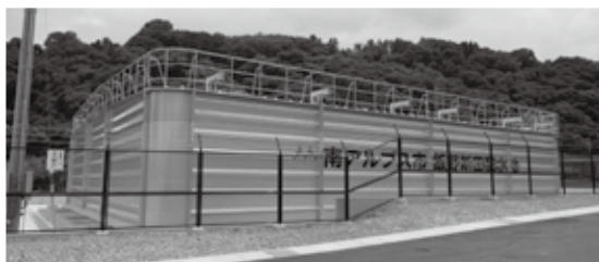
令和2年12月に完成した飯野新田配水池
