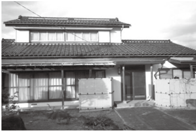
▶ 市内で空き家となっている住宅
