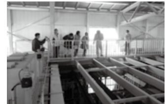
駒場浄水場の沈殿池
