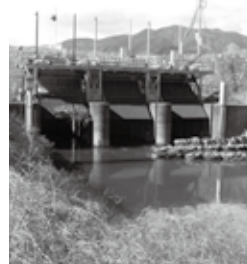
横川にある樋門 (東南湖地内)
