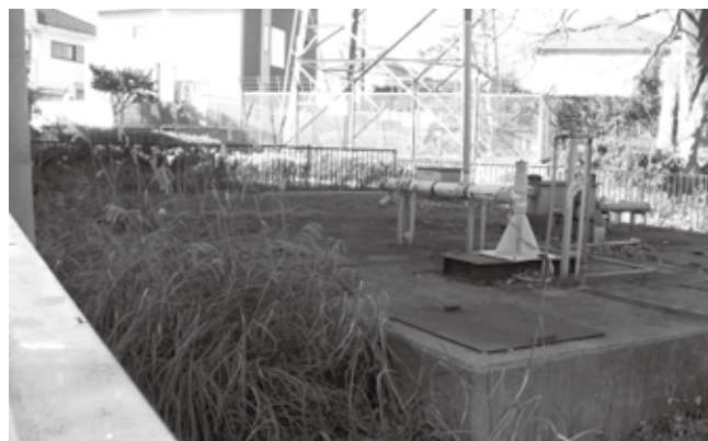
広域下水道に接続し不要となったコミュニティプラント (白根高南団地浄化センター)
