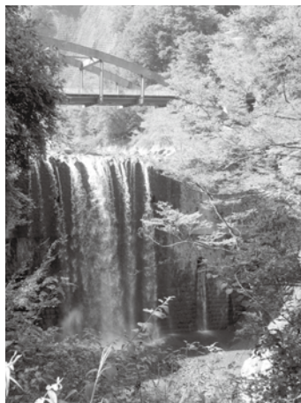
国の登録有形文化財になっている芦安堰堤
