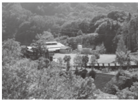
配管等の改修予定の金山沢温泉
