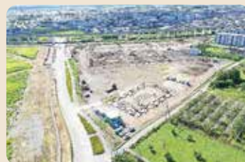
◀ 工事中の御勅使南工業団地
