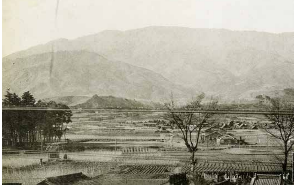
戦後すぐとみられる小笠原・山寺周辺の写真。画面左に見える林が山寺八幡神社。その手前に修理作業中とみられる小笠原長清公祠堂が見える(小笠原町町制十五周年記念写真帳より)。
