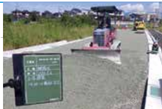
道路の新設工事
