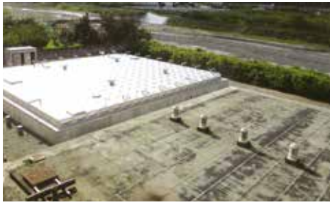
新配水池(奥)と更新予定の浄水池(手前)
